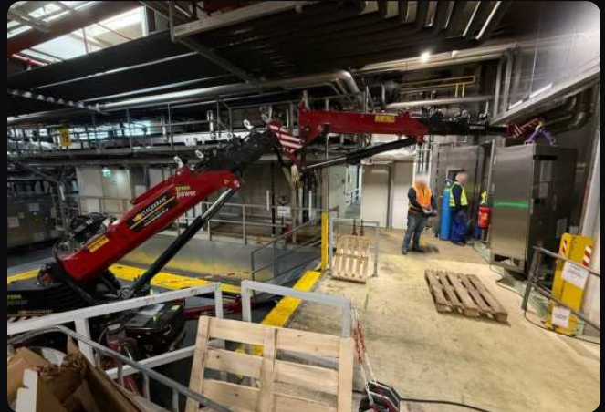
Hallenmontage im laufenden Betrieb
