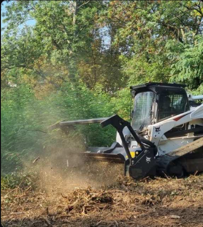
Der Mulcher arbeitet sich durch den Aufwuchs
