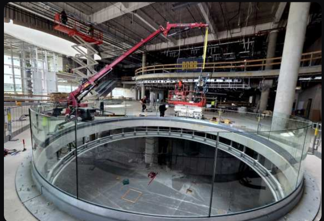
Glasring über der Decke gesetzt
