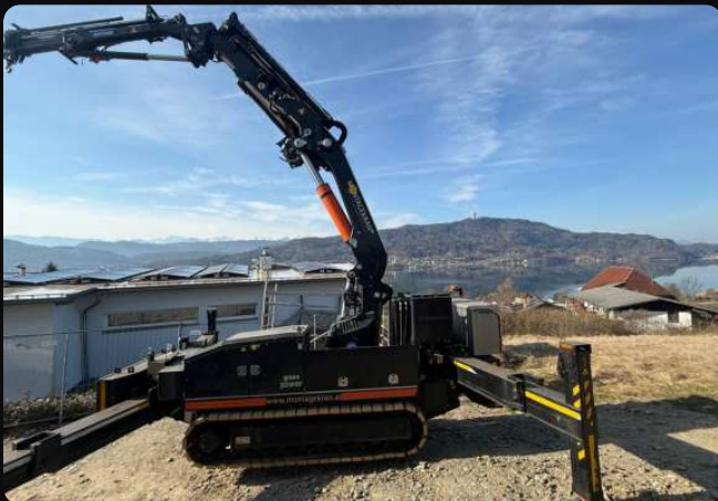
Stahlbau am Seeufer
