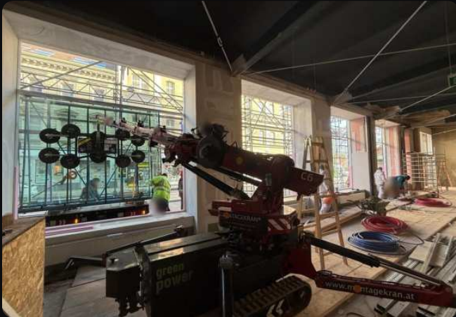
Verglasung im fertigen Innenraum
